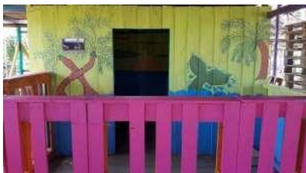
Fig. 6. Elaboración de elementos de identidad cultural (arriba). La figura muestra en su parte inferior, los elementos terminados, donde se aprecia los elementos de acceso y cerramiento elaborados también con estibas de madera.
