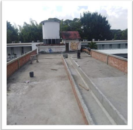
Foto 12. Reparaciones Locativas en la Biblioteca con un área de 1.720
