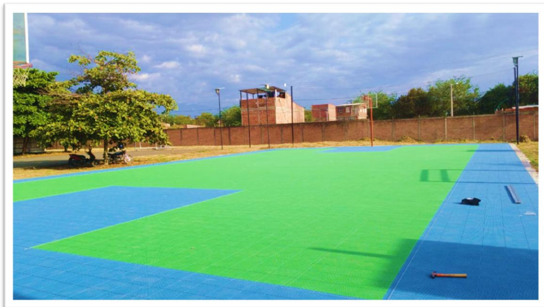
Foto 10. Construcción del Parquedero de Motos.
