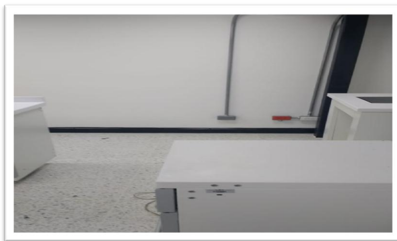
Foto 14. Reparaciones eléctricas en el laboratorio de física.
