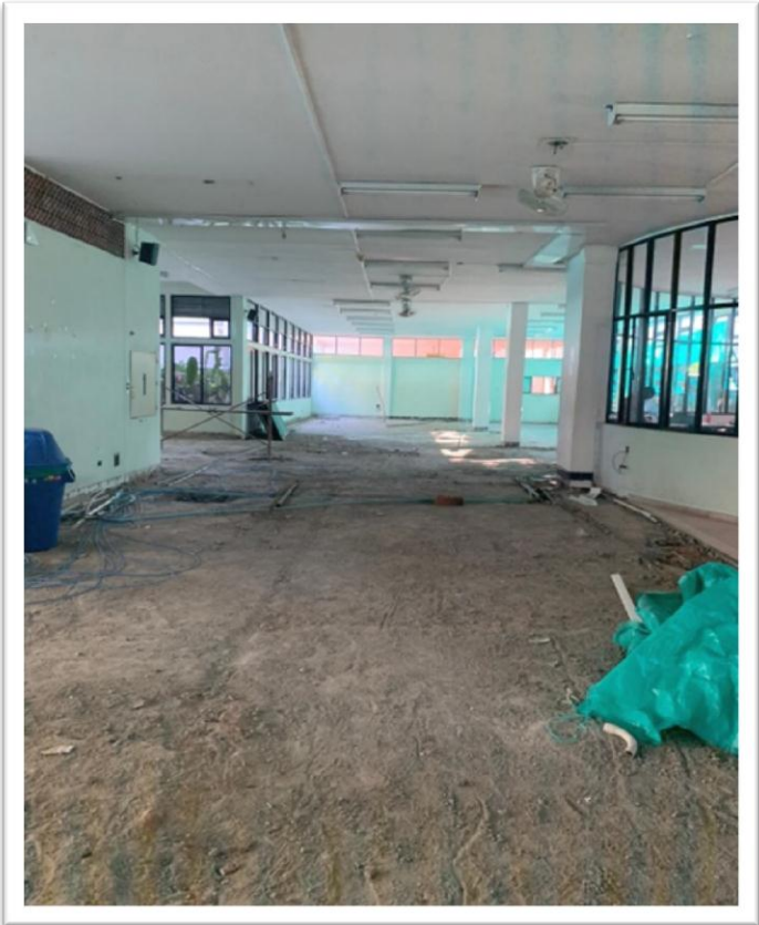
Foto 13. Reparaciones Locativas en la Biblioteca.
