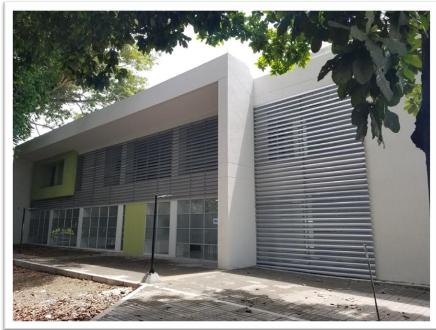
Foto 4. Obra finalizada. Edificio de apoyo y servicios para el bienestar universitario. Sede Palmira (vista lateral izquierda).
